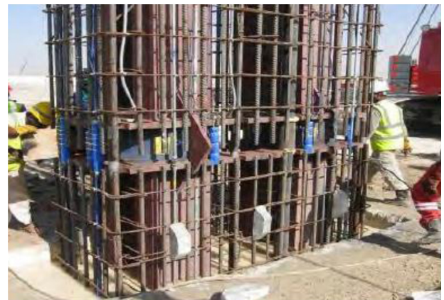
Fig. 9. Insertion de la cage équipée de vérins O-Cells.
