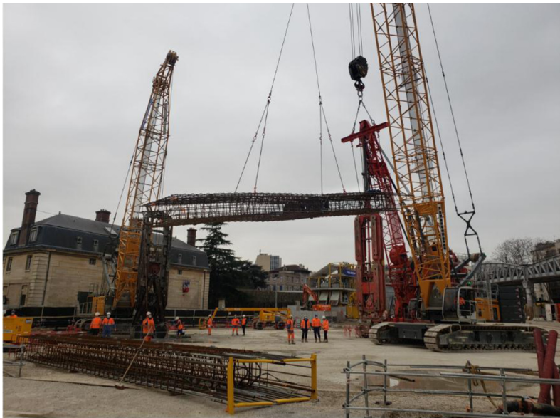
Fig. 11. Insertion d'une section de cage.
