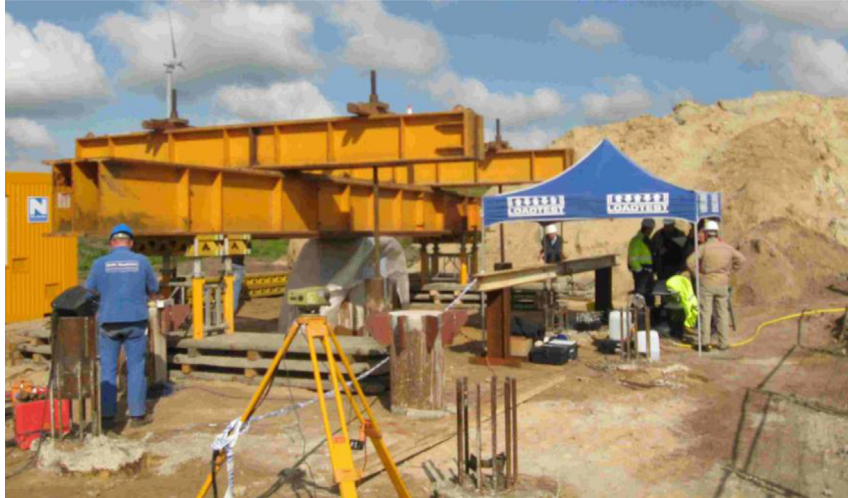
Fig. 3. Comparaison essai avec vérin en tête et massif de réaction (partie gauche) et essai avec vérin embarqué et simple poutre de référence (partie droite).
