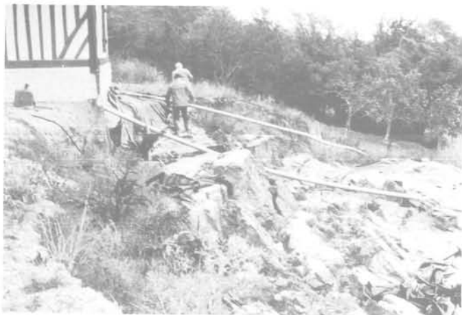
Fig. 6 - Le glissement en-dessous de la plateforme (B)
