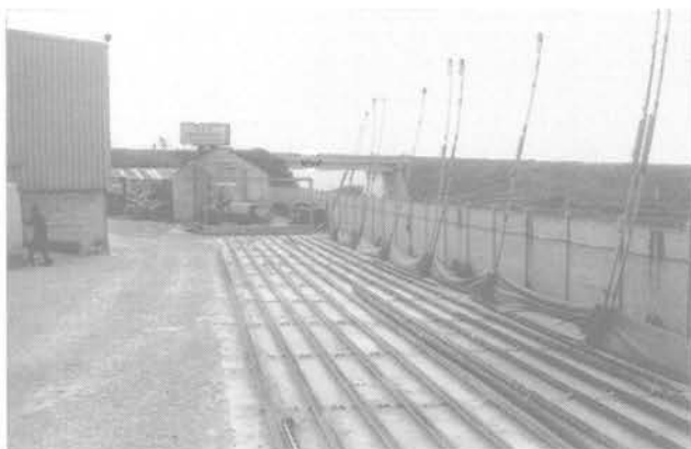
Fig. 7. — Aire de préfabrication des barres INTRAPAC.
