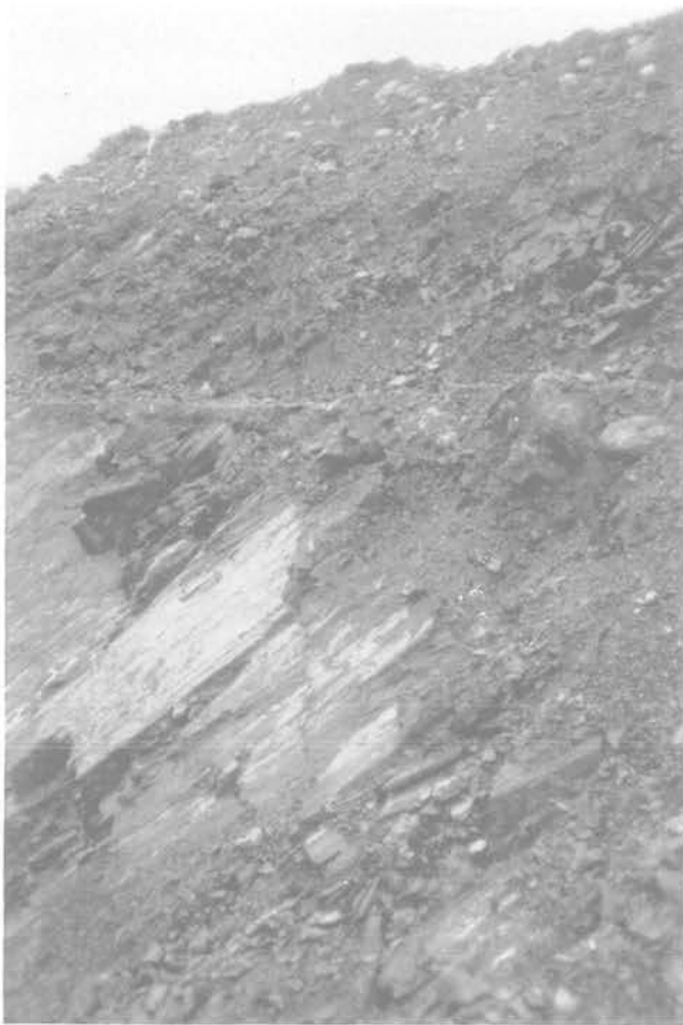
Fig. 3a. — Glissement survenu dans les schistes au voisinage de la fouille de l'usine.
