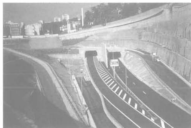
FIG. 1 Tranchée de Pierre-Baizet, têtes est des tunnels de Rochemard. Pierre-Baizet trench and Rochemard eastern portal.
