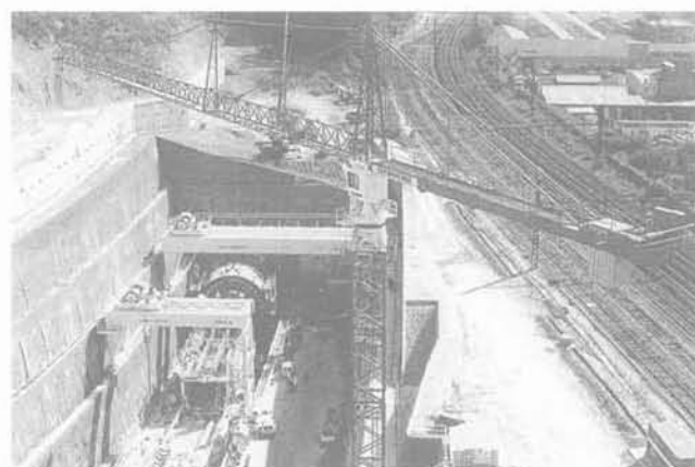
FIG. 2 Montage du tunnelier dans la tranchée (juillet 1994). Setting up of EPB — shield in trench (1994, July).
