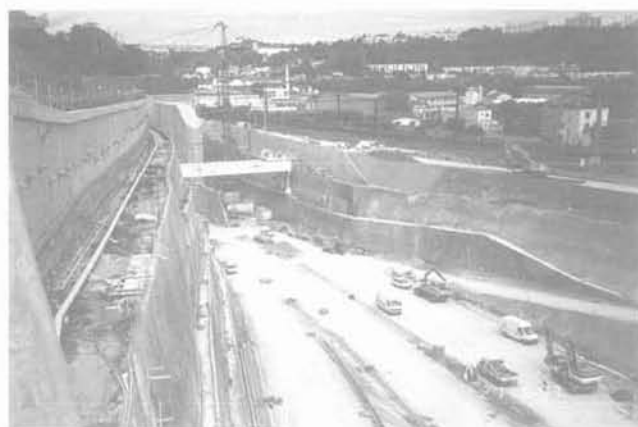
FIG. 15 Vue perspective de la tranchée vers l'est (mai 1997). Final eastward view in perspective through trench (1997, May).
