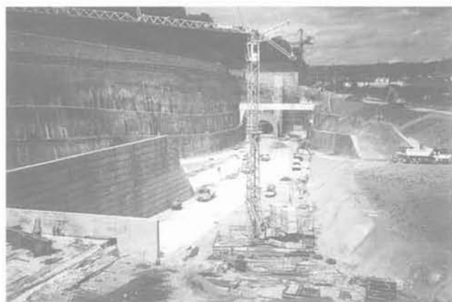
FIG. 4 La tranchée Pierre-Baizet (vue est) en fin de travaux (mai 1997). Final eastward view of Pierre-Baizet trench (1997, May).
