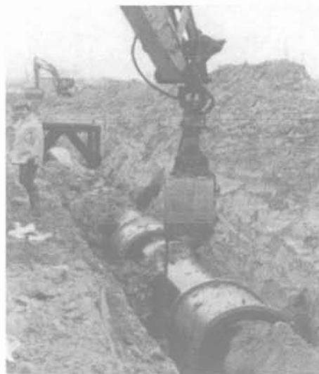
PHOTO 6 Remblayage de la conduite.
