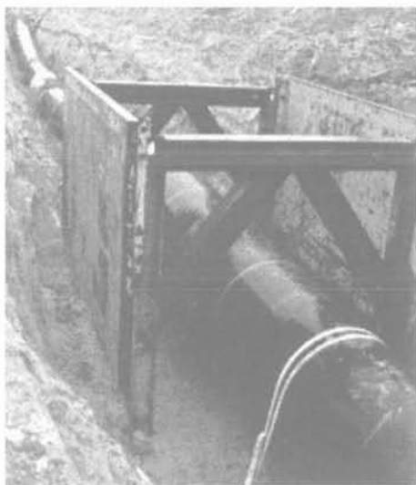
PHOTO 5 Les ancrés et les sangles sont installés.
