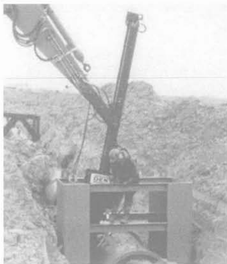
PHOTO 3 Battage des ancrés, la conduite étant protégée par un châssis.
