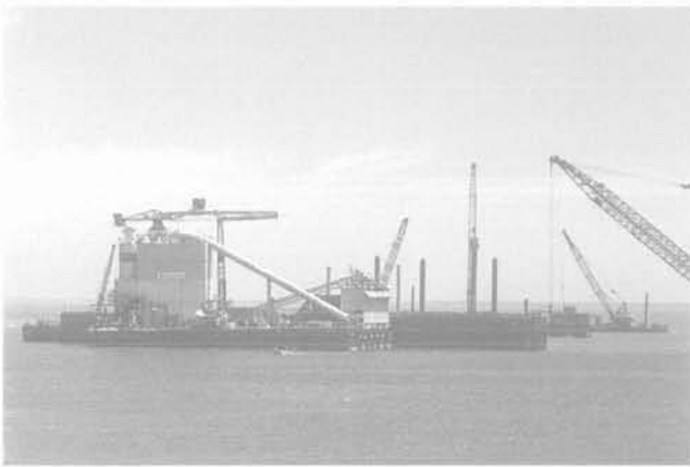
FIG. 4 Centrale à béton flottant. Floating batching plant.
