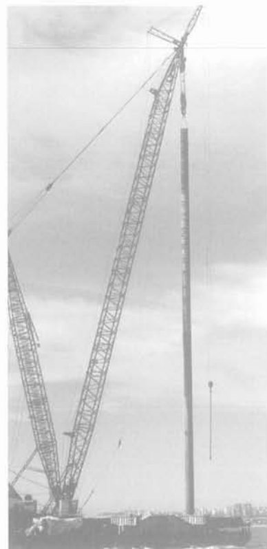
FIG. 8 Mise en fiche d'un pieu battu. Placing of a pile into driving position.
