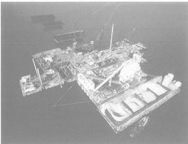
FIG. 5 Vue d'ensemble d'un batardeau de pylône. Overall view of a pylon cofferdam.
