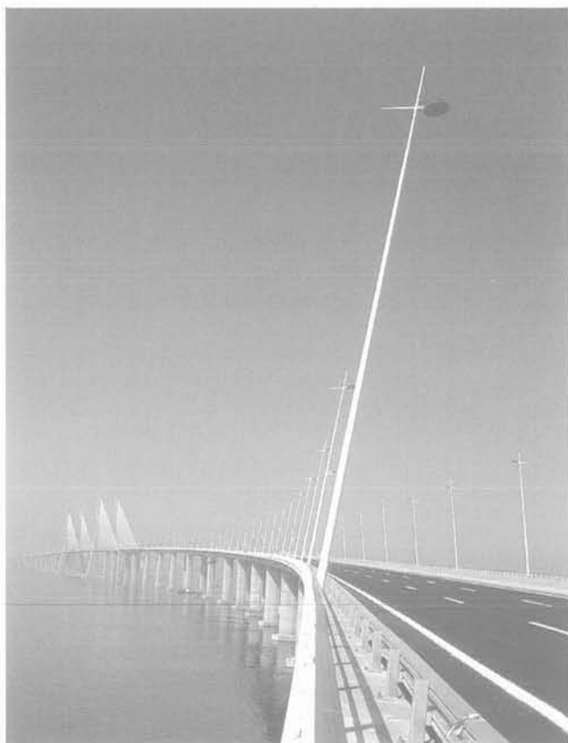
FIG. 1 Vue générale depuis le viaduc central avec le pont principal à haubans en fond. General view taken from central viaduct towards main cable stay bridge.
