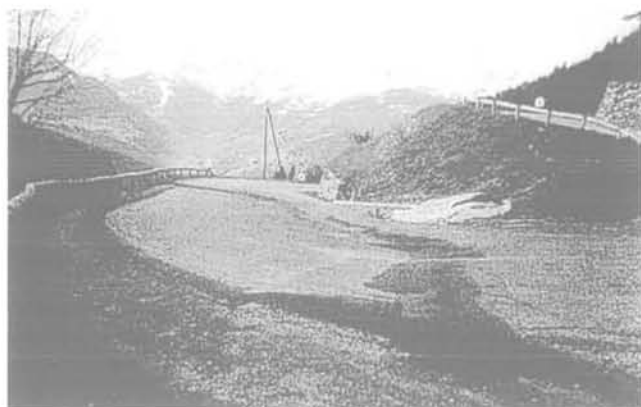
FIG. 4 Vue générale du site avant travaux. The landslide before road works.
