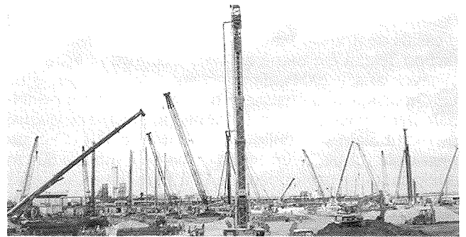
FIG. 13 Exécution parallèle de pieux battus, de pieux forés et de colonnes ballastées (Keller Fondations Spéciales, 2009). Parallel execution of driven piles, bored piles and stone columns (Keller Fondations Spéciales, 2009).
