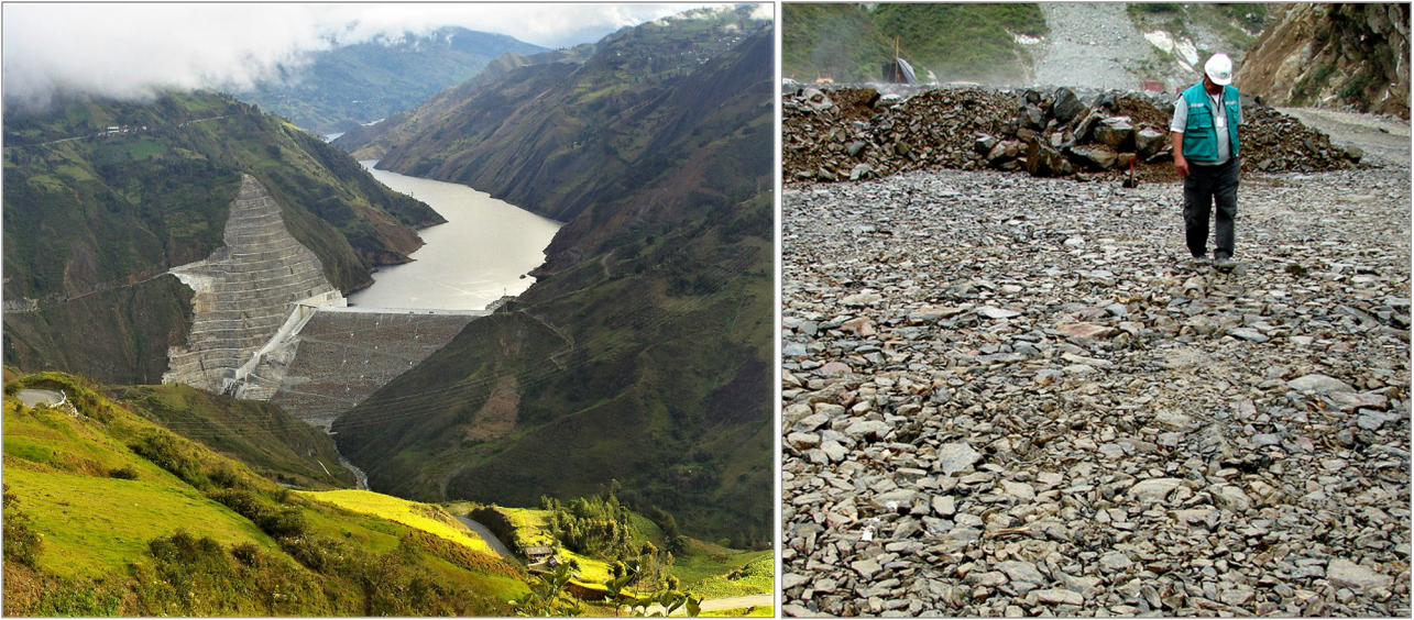
Fig. 1. Un grand barrage en enrochement, et l'enrochement utilisé dans sa construction.
