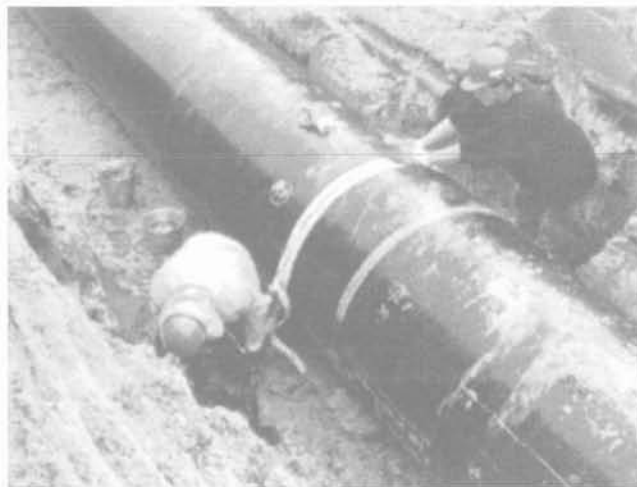
PHOTO 4 Mise en place des ancres de kevlar.
