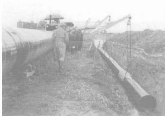
PHOTO 2 Mise en place de la conduite.
