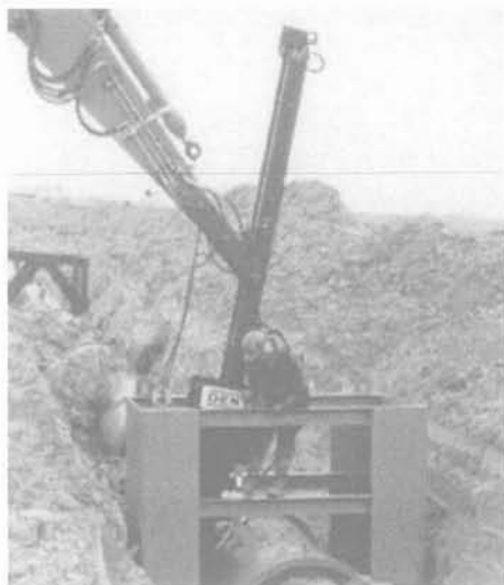
PHOTO 3 Battage des ancres, la conduite étant protégée par un châssis.
