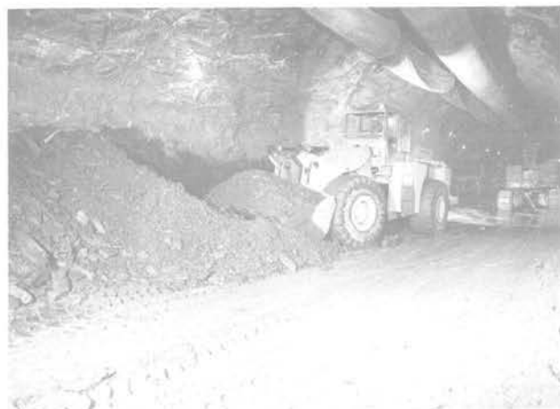
Fig. 25 Mise en cordon des déblais
