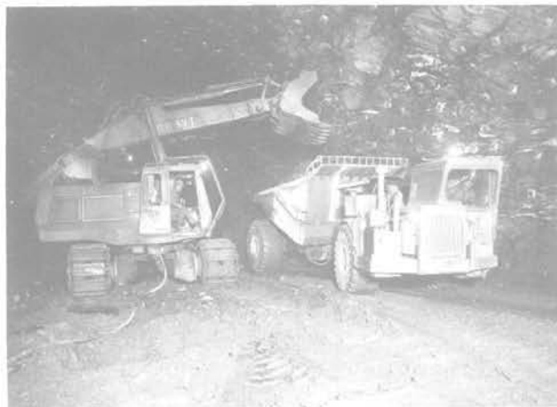
Fig. 24 Chargement des dumpers
