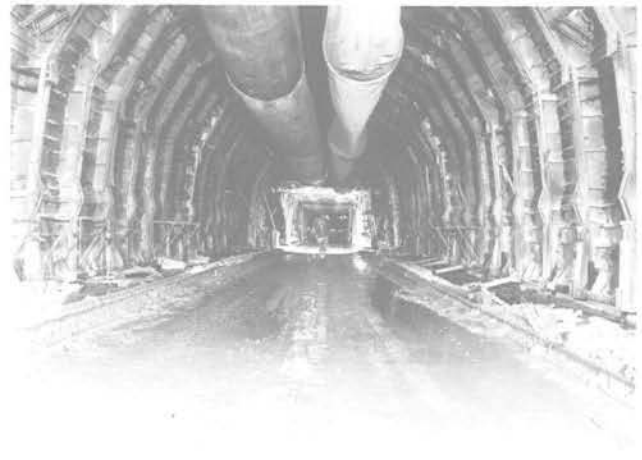
Fig. 29 Bétonnage de la voûte
