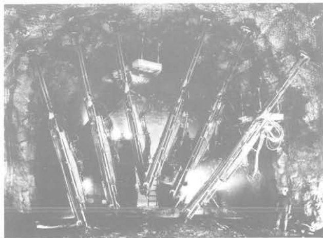
Fig. 26 Boulonnage de la voûte
