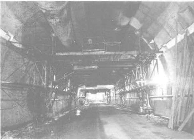
Fig. 30 Bétonnage de la dalle de plafond
