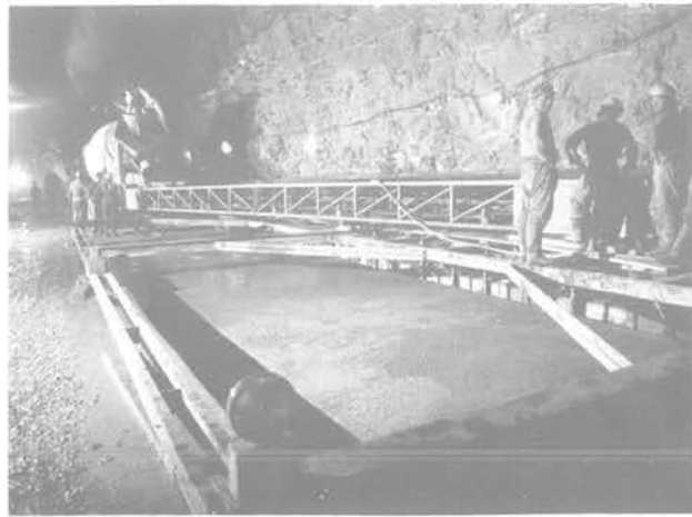
Fig. 27 Coulée des banquettes de fondation de la voûte et du béton de roulage
