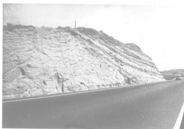
Fig. 7 et 8 Parois de tranchées routières dans l'île de Ténériffe, route de Santa Cruz à l'aéroport
