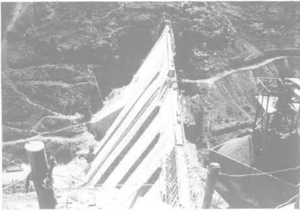
Fig. 28 Photographie du barrage «Arinez» : la fouille et l'élargissement de la section en rive droite sont bien visibles
