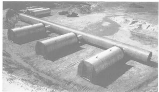
Fig. 3. — Montage des buses avant remblaiement.
