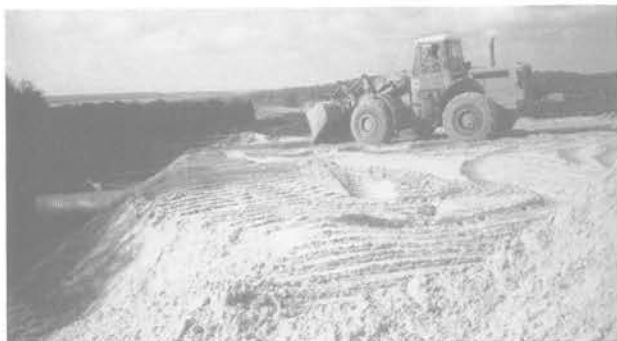
Fig. 5(a). — Remblaiement des buses terminé.
