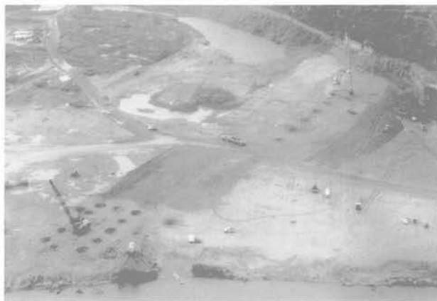
Fig. 11. — Vue générale du site : au premier plan le bras de droite du Grijalva, puis l'atelier de consolidation dynamique avec une grue, enfin l'atelier du tripode sur le bras de gauche du fleuve remblayé.
