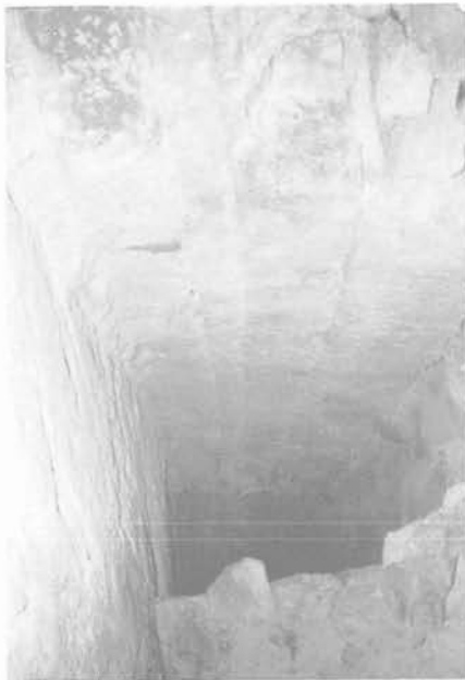
Fig. 22. — Ivry-sur-Seine. Galerie souterraine.
