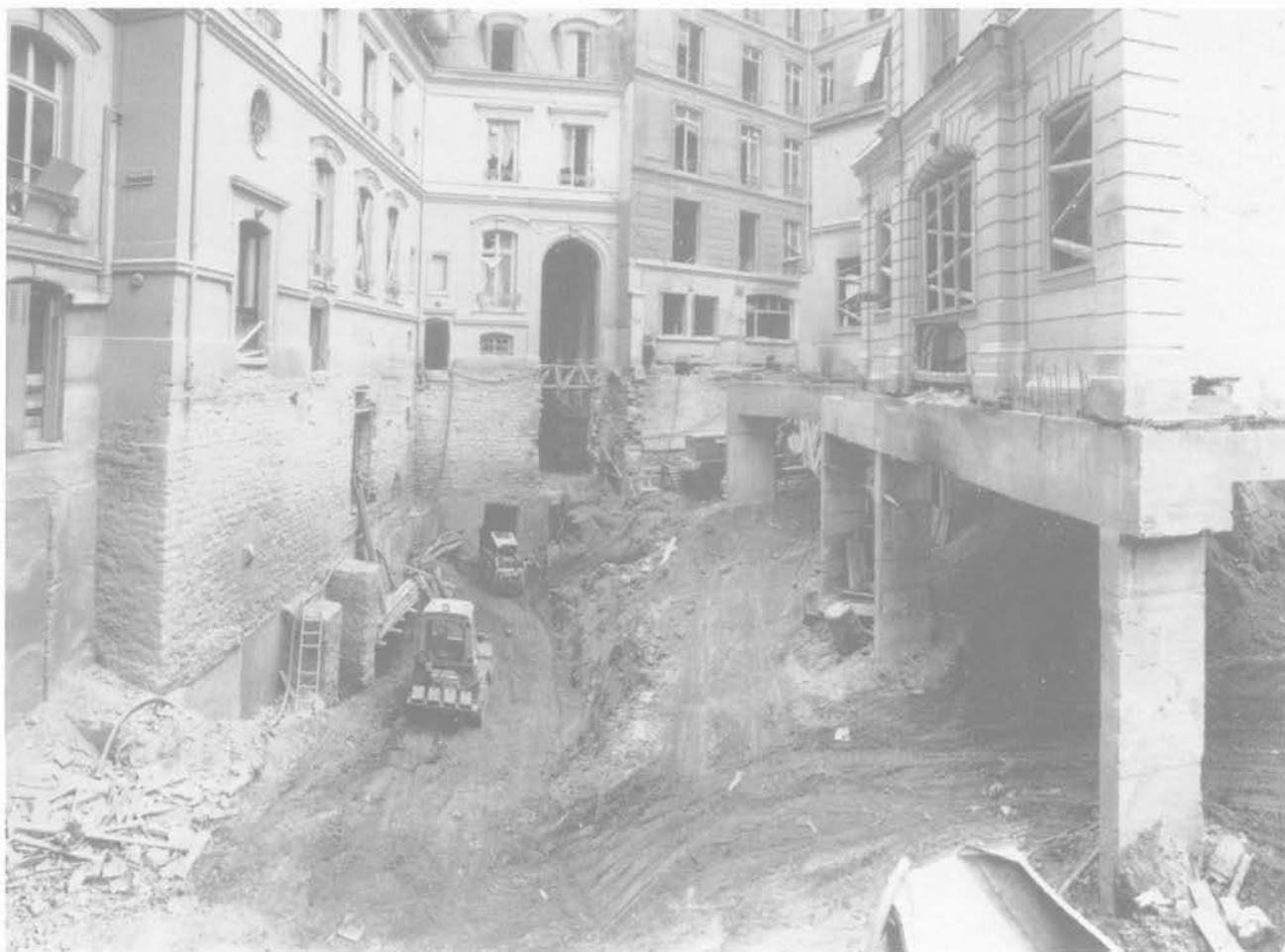
Fig. 19. — Rue Paul-Baudry - Paris (8 e ). Achèvement de l'excavation générale.
