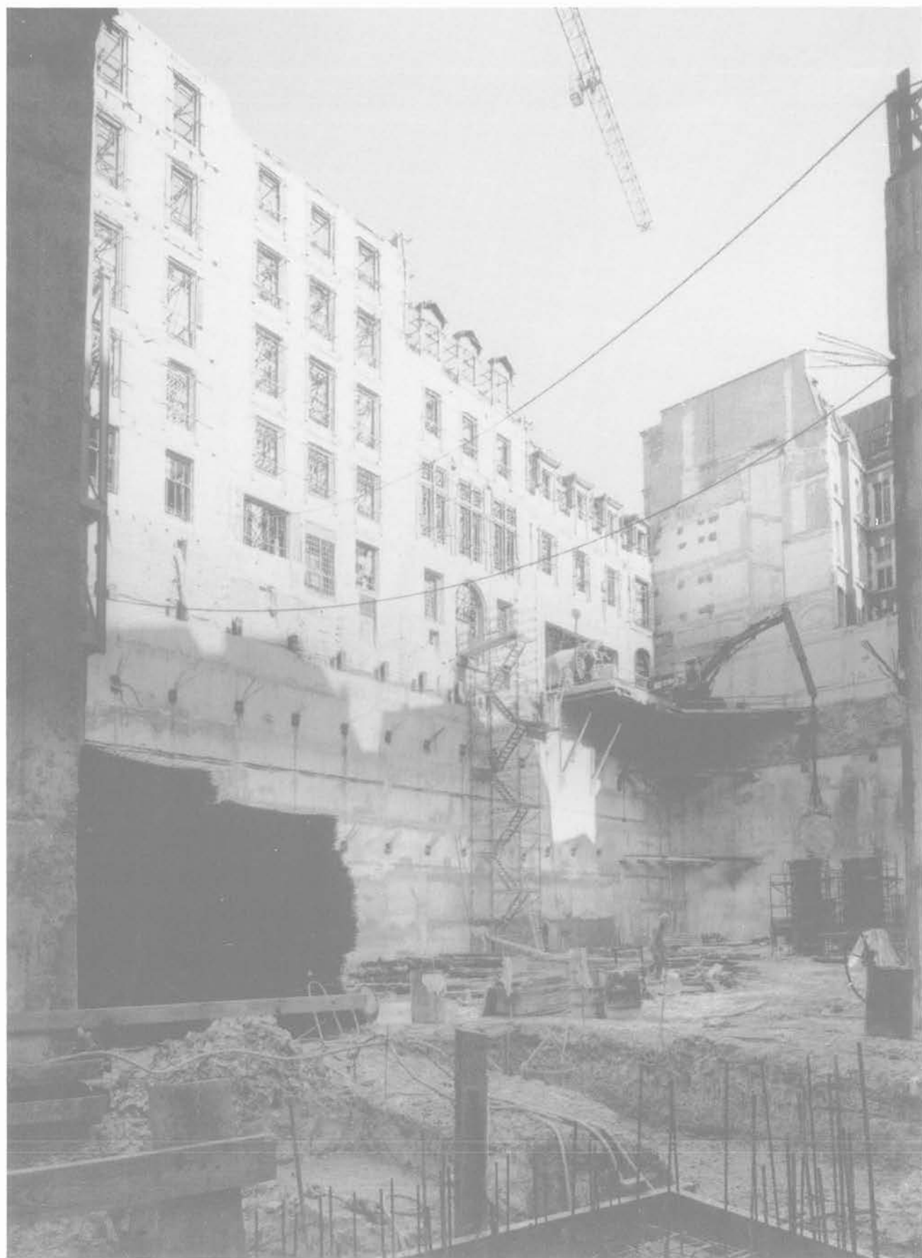
Fig. 11. — Rue Galilée - Paris (16 e ). Façade rue Vernet avec paroi berlinoise.
