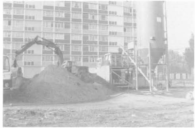
Fig. 23. — Ivry-sur-Seine. Installation d'injection.
