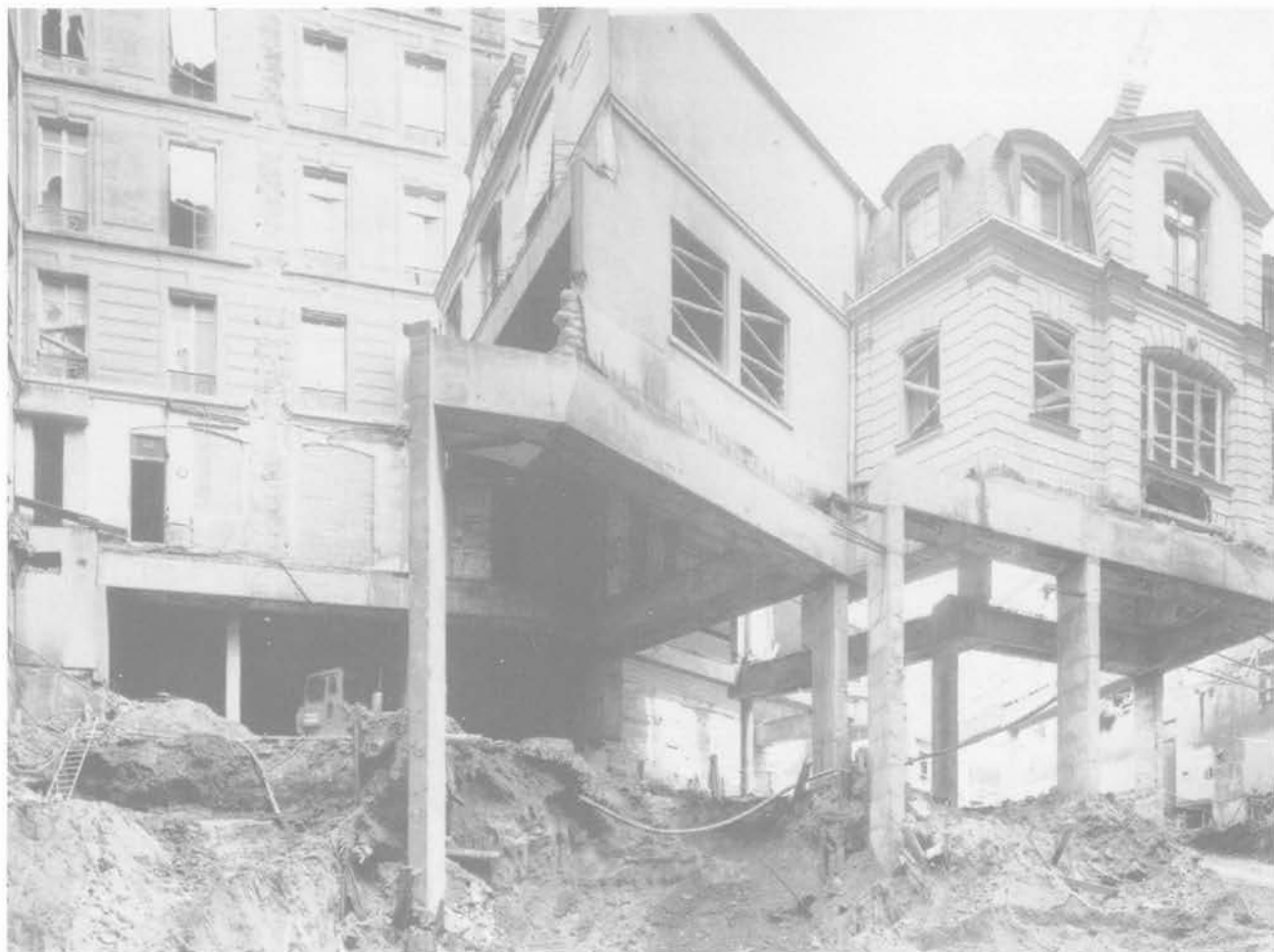
Fig. 20. — Rue Paul-Baudry - Paris (8 e ). Vue des immeubles repris en sous-œuvre.
