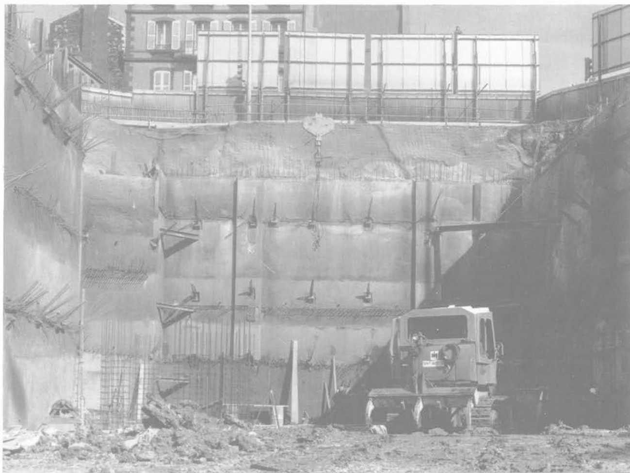
Fig. 15. — Clermont-Ferrand. Vue partielle du chantier.
