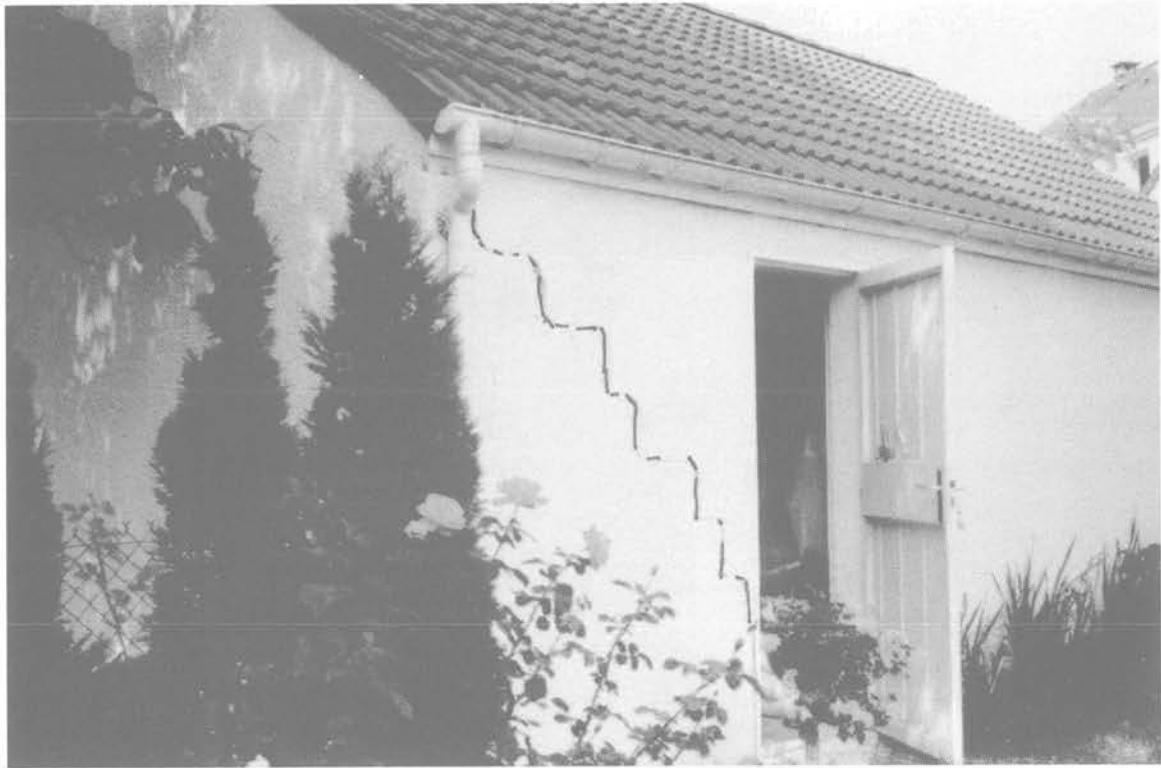
Fig. 3. — (Cliché SIMECSOL). Pavillon fondé sur les marnes infragypseuses à Sarcelles (Seine-St-Denis). Fig. 3. — Villa settled on infra-gypseous marl in Sarcelles (Seine-St-Denis).
