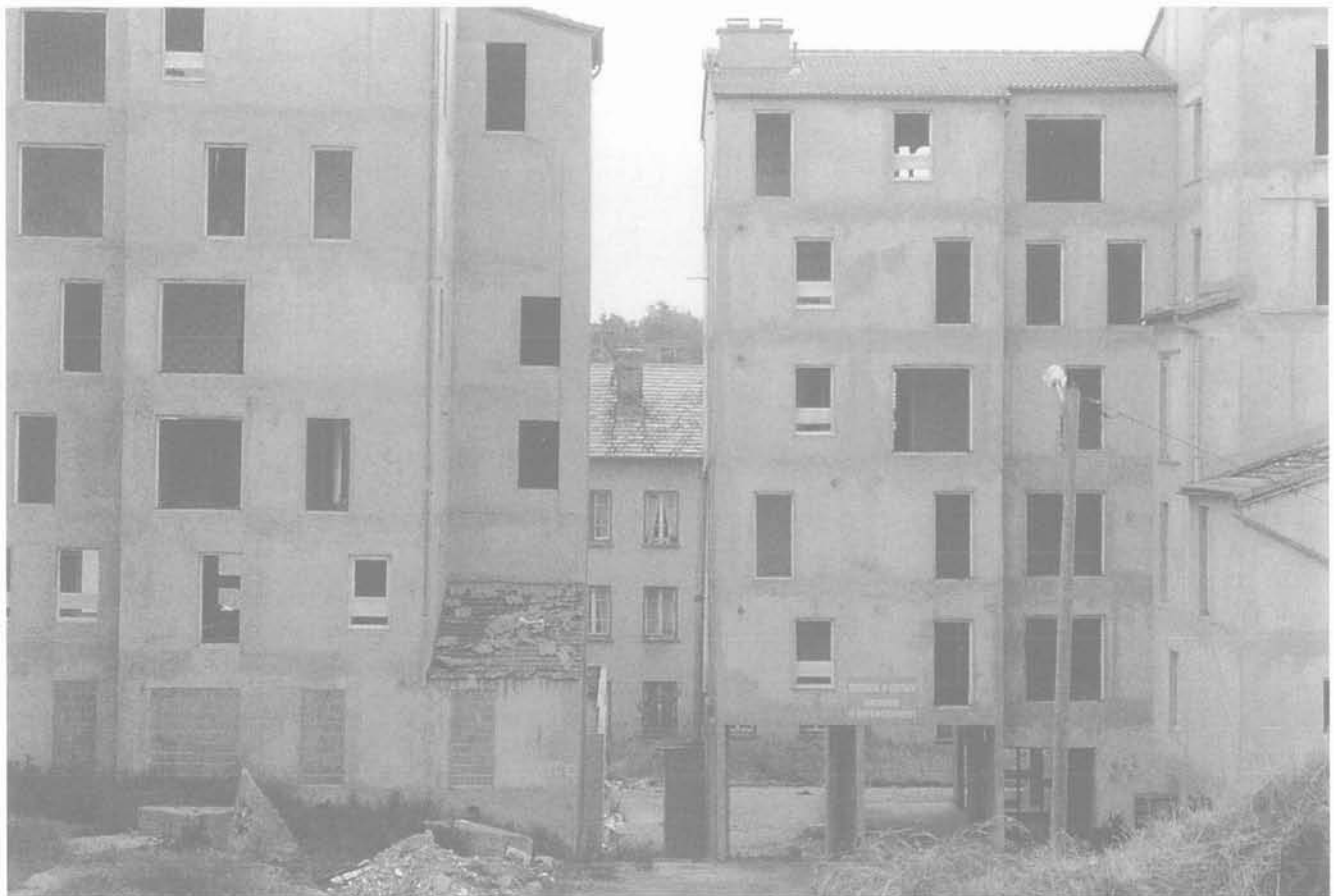
FIG. 6 Après la démolition de la jonction des bâtiments A et B. Buildings A and B after the removal of their junction.
