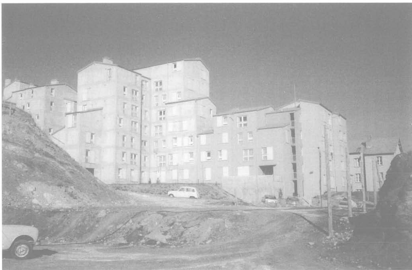
FIG. 1 Vue d'ensemble des bâtiments du Petit Clos sinistrés. Au premier plan fouille de pleine masse de l'opération « Vallée de l'Ondaine ».
