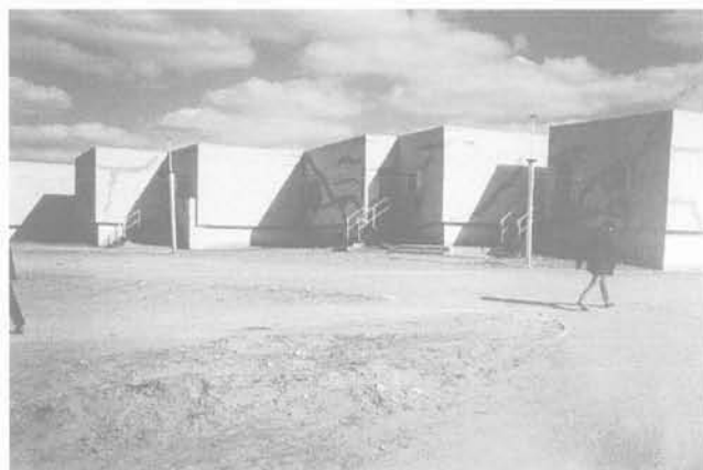
FIG. 9 Fissures diagonales de cisaillement dues à un gonflement différentiel à l'angle du studio.
