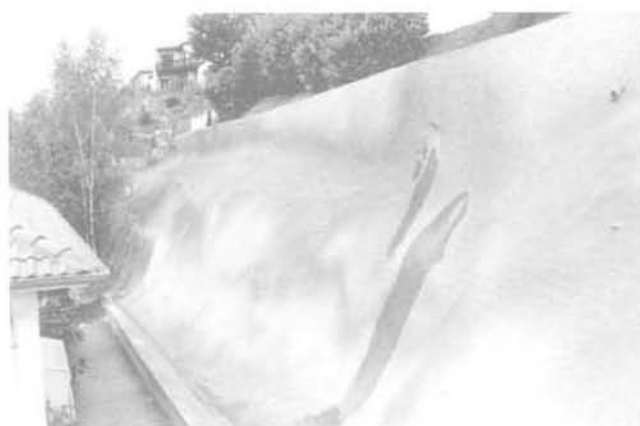
FIG. 5 Confortement réalisé en 1987 (photographie du 14 octobre 1987). Repair works made in 1987 (picture on October 14, 1987).
