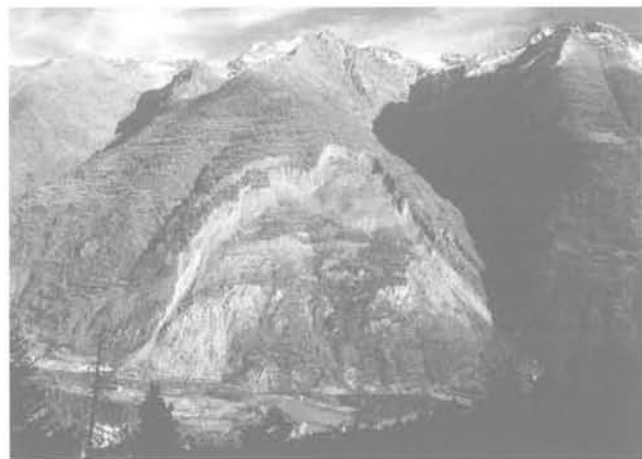
FIG.8 Vue sur le glissement de La Clapière en 1998. La Clapière landslide in 1998.
