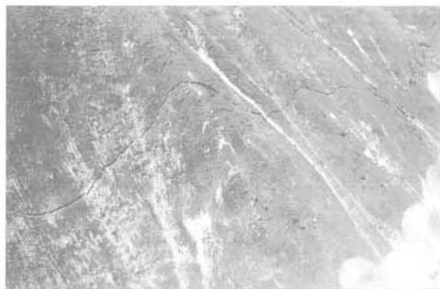
FIG. 3 Crevasse de tête du glissement du Billan. Billan slide : Uphill tension crack.
