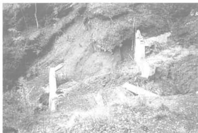
FIG. 1 Action d'une berge instable sur un barrage de correction torrentielle de type consolidation. Torrent control dam submitted to the thrust of an unsteady bank.
