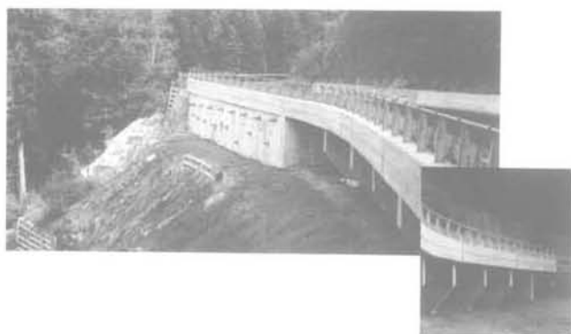
FIG. 7B État après les travaux (photo : HCB, 2000). After road works.
