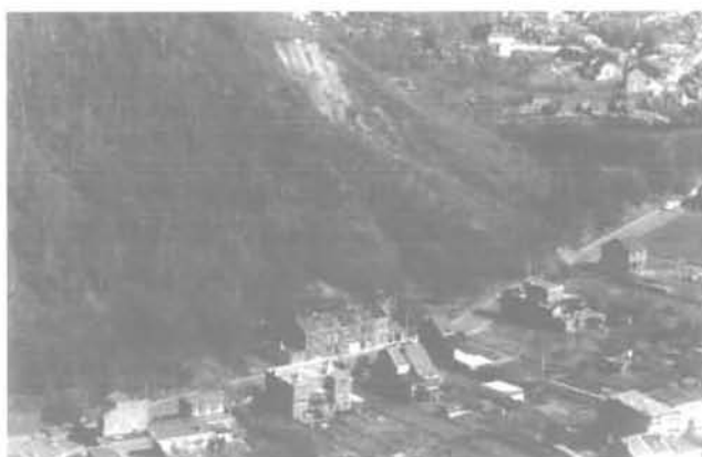
FIG. 3 Terril de la petite Bacnure à Herstal : vue générale du glissement. Petite Bacnure spoil heap in Herstal : General view of the landslide.
