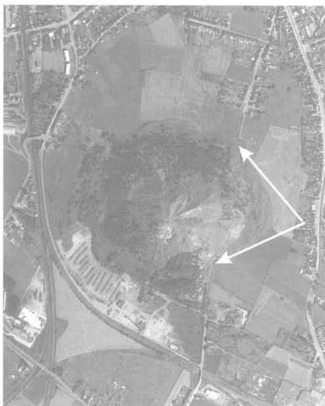
FIG. 16 Vue aérienne du terril de l'Héribus et de la coupure de la route de Bavay. Aerial view of the Héribus spoil heap and of the cutting of the Bavay road.
