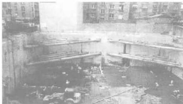
FIG. 4 Un exemple de butonnage d'un coin.
