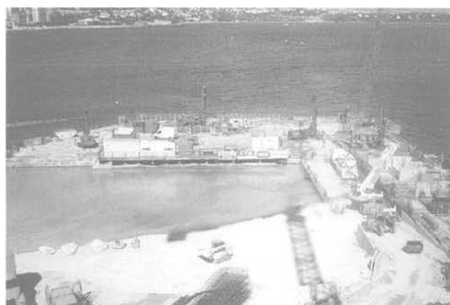
FIG. 6 Injections solides à partir de la surface de la culée.
