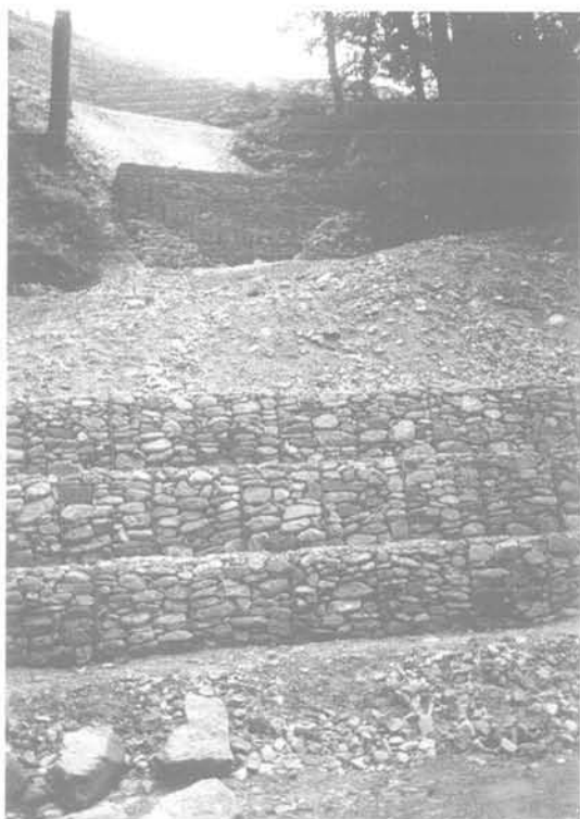
FIG. 10 Glissement du talus de la route n° 45109 à Międzygórze : construction de la protection du talus routier à l'aide d'un système des gabions. Embankment landslide of road n° 45109 in Międzygórze. The road embankment is protected by gabions system.
