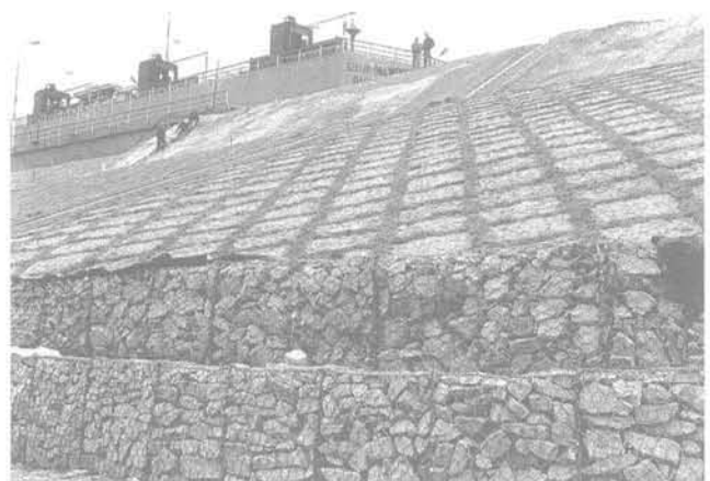
FIG. 6 Renforcements des talus du remblai. Reinforced road embankment.
