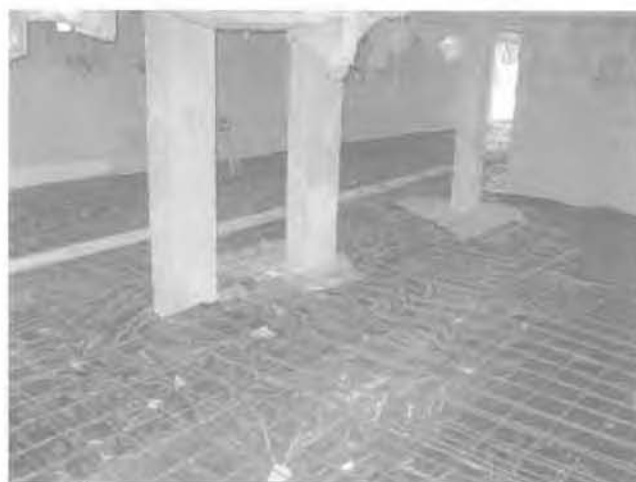
FIG. 19 Treillis soudé avant coulage du béton de dallage. Girder before casting of pavement.
