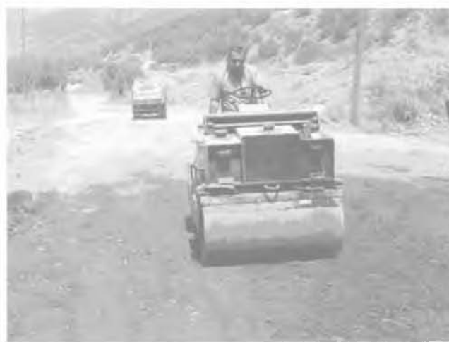
FIG. 5 Compactage des couches de remblai. Compaction of embankment layers.
