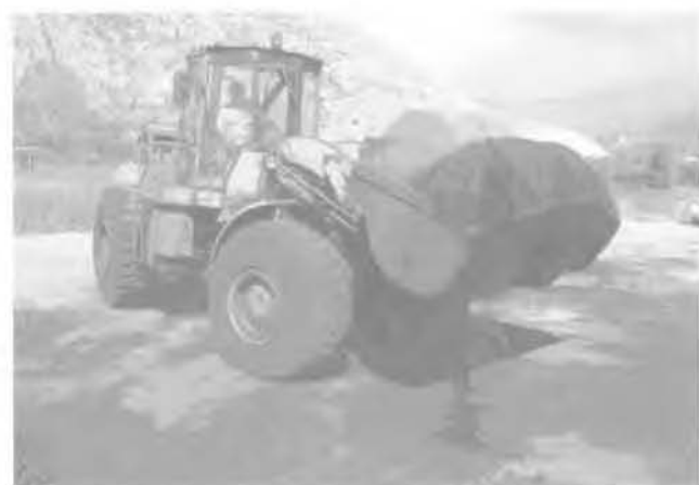
FIG. 4 Apport de matériau. Transfert of material.
