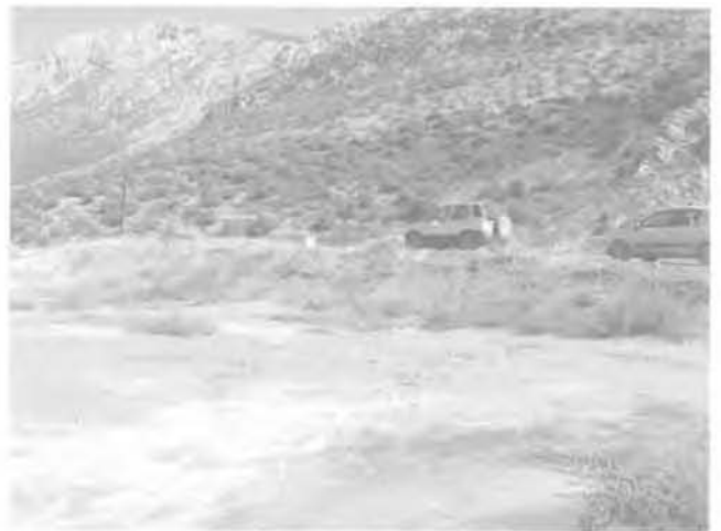
FIG. 7 Le remblai routier cinq ans après (2008). The road embankment five years after construction (2008).
