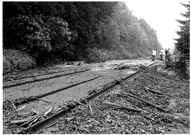
FIG. 3 Coulée boueuse sur plate-forme ferroviaire. Slurry flow on railway trackbed.
