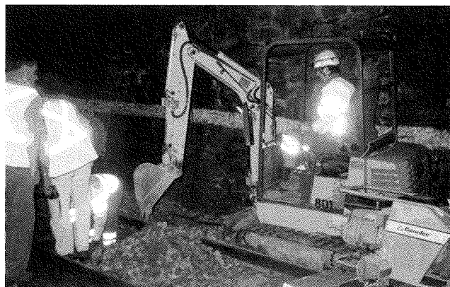
FIG. 5 Fouille mécanisée en plate-forme. Investigation using engine on platform.
