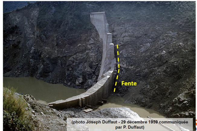
Fig. 2. Le barrage de Malpasset peu après sa rupture. À gauche, la rive gauche avec la trace du dièdre de rocher emporté ; à droite, la rive droite avec le bas du barrage intact mais une crevasse décimétrique ouverte à l’amont dans sa fondation.
